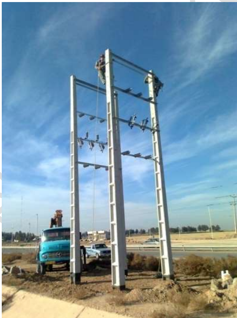
نحوه نصب یراق آلات روی پایه ها
