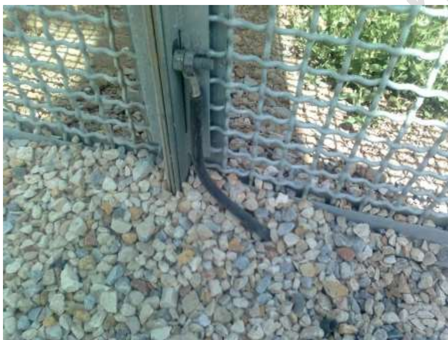
اتصال زمین فنس اتوبوستر به طور جداگانه
