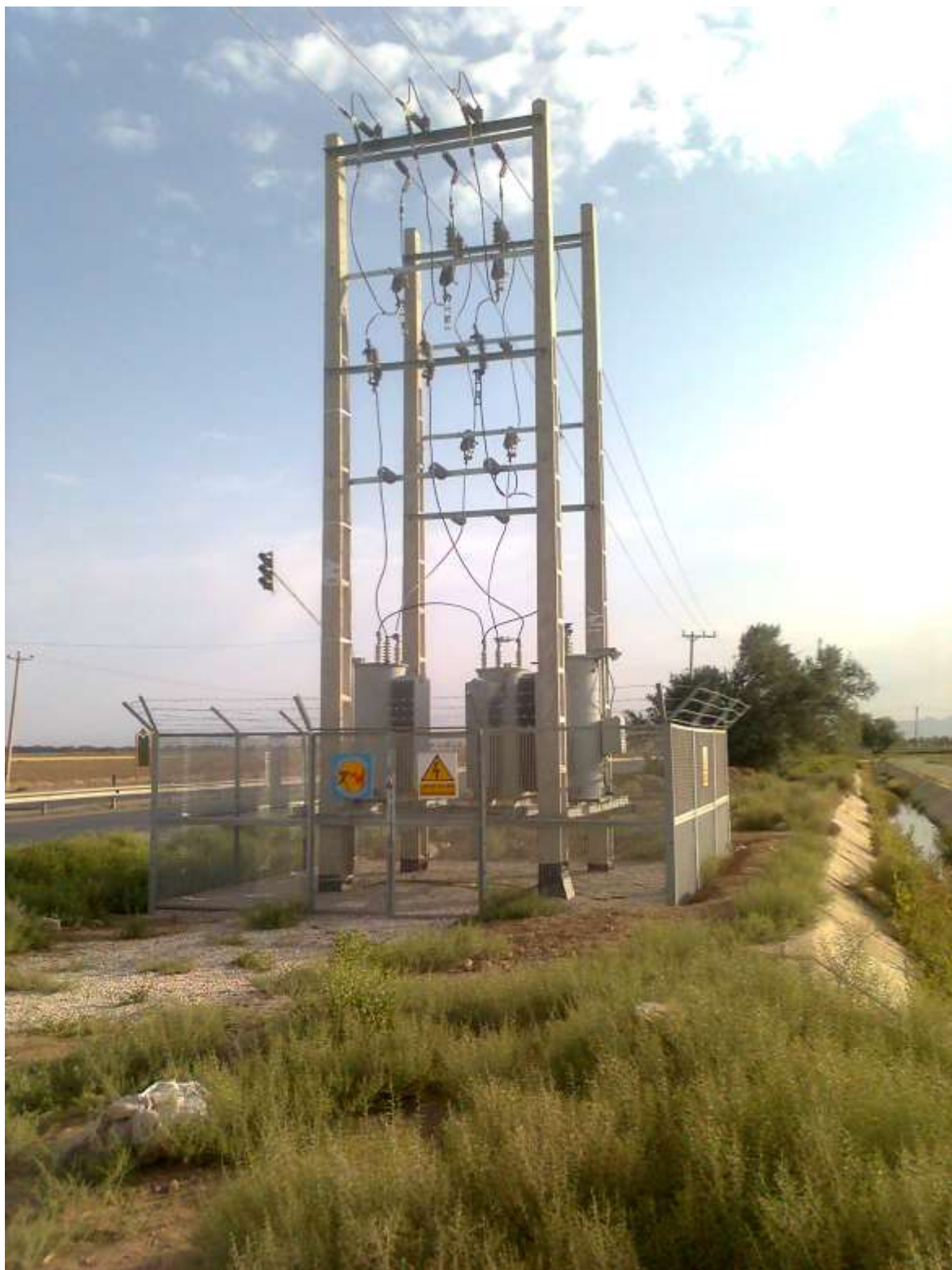
نمایی از پروژه نصب اتوبوستر
