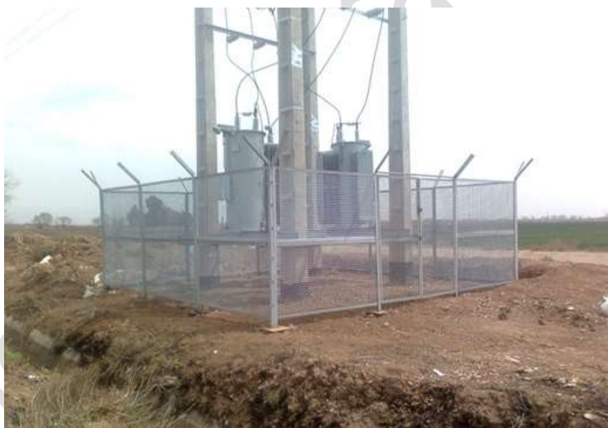
نصب فنس اتوبوستر
