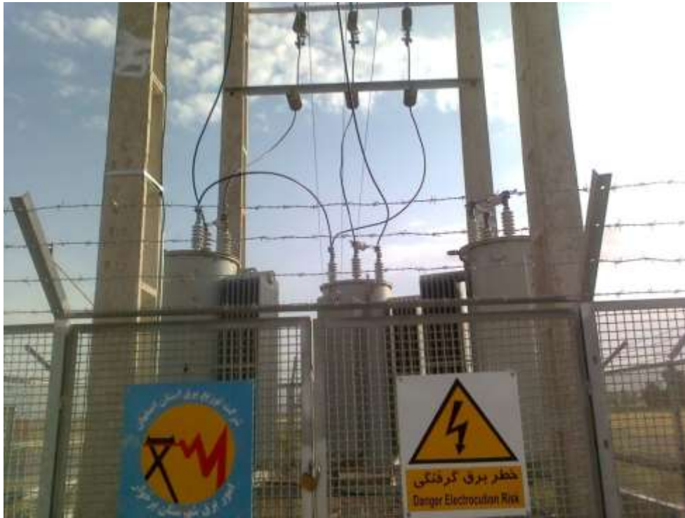
نحوه اتصال دو دستگاه اتوبوستر به شبکه سه فاز
