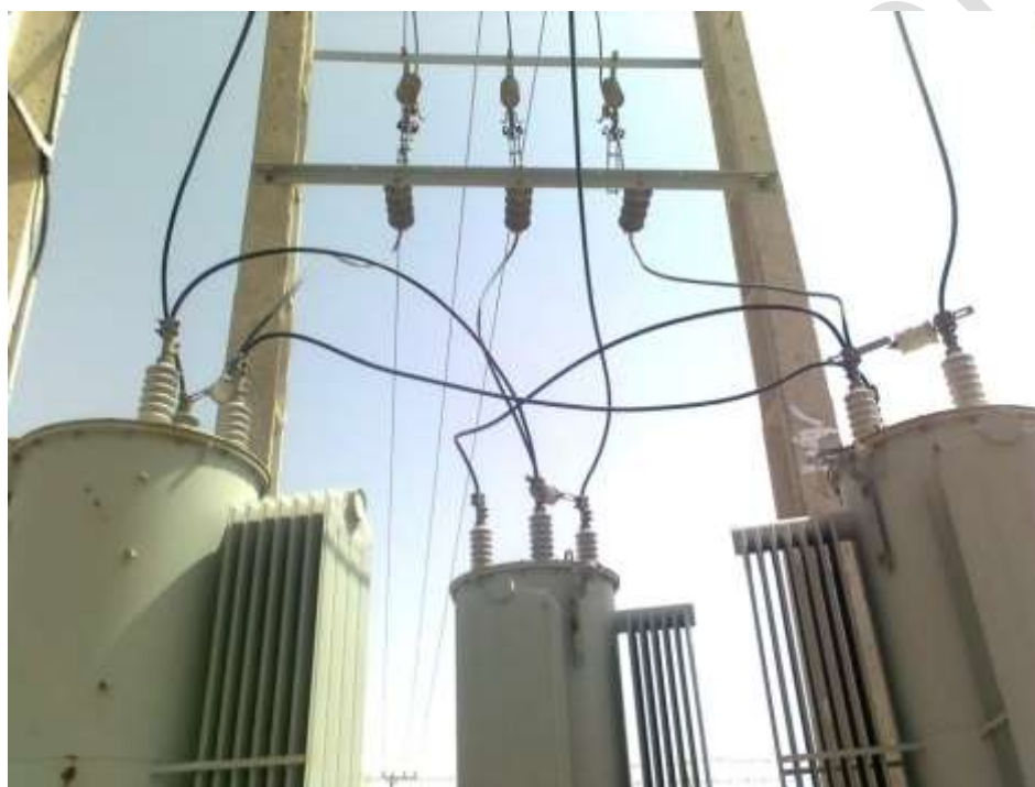
نحوه اتصال سه دستگاه اتوبوستر به شبکه سه فاز
