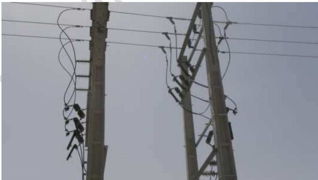
نحوه نصب کت اوت ها و اتصالات بالا و پایین کت اوت
