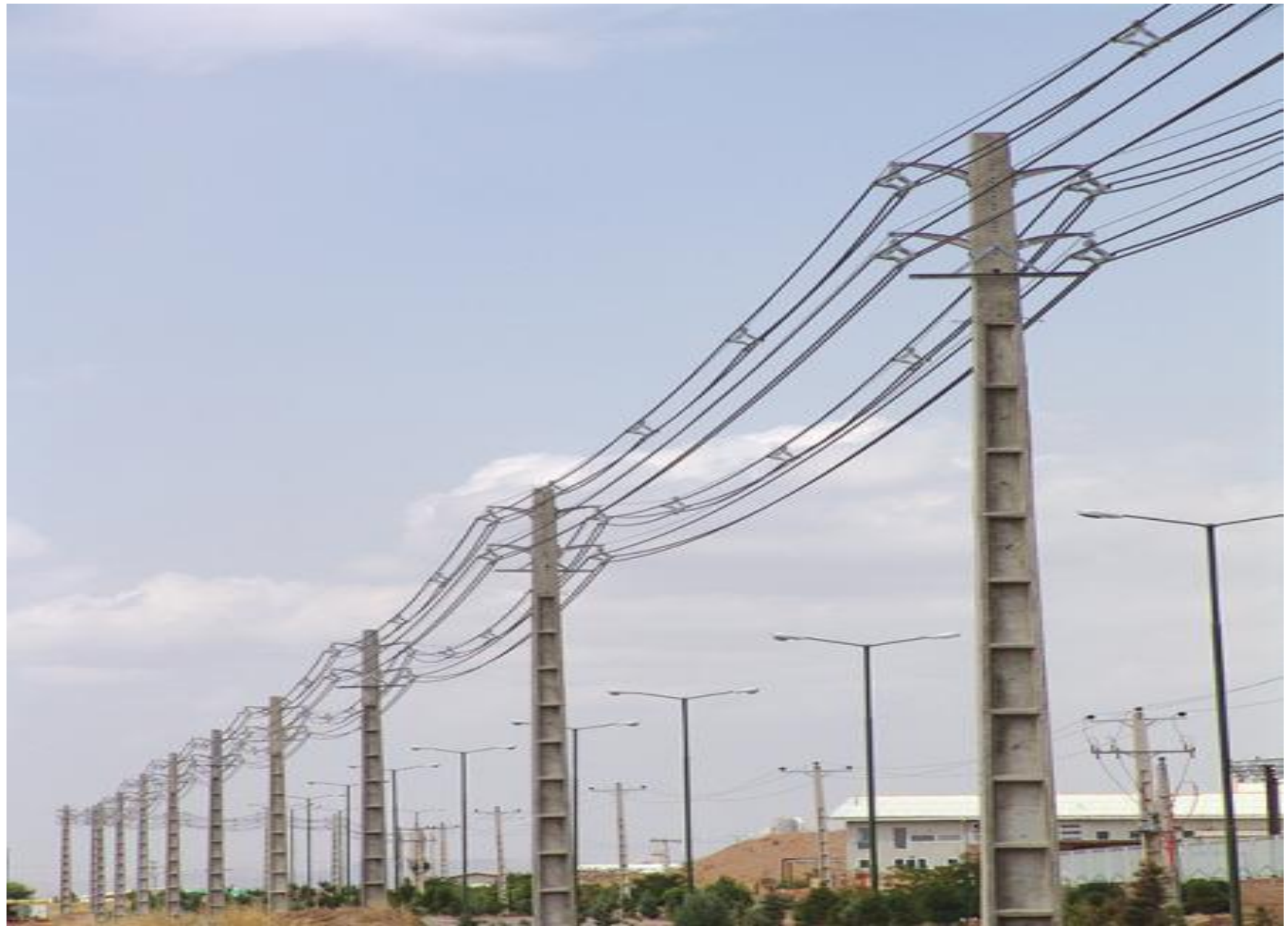
شبکه ۴ مداره با کابل فاصله دار هوایی
