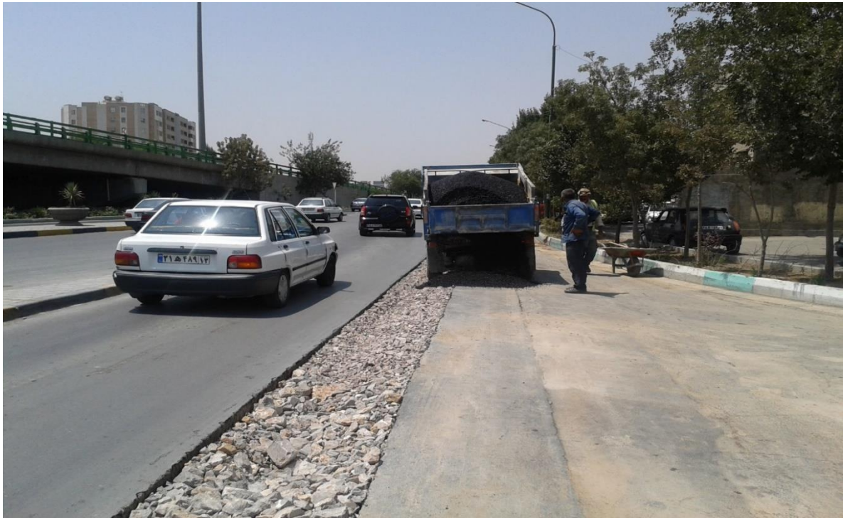
عدم نصب علائم هشدار دهنده و محصور نمودن محیط کار و همچنین عدم حضور نفر پرچم زن
