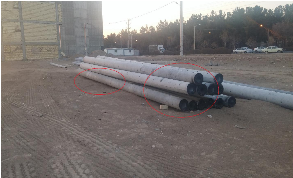
دپوی پایه‌ها به صورت نا ایمن
