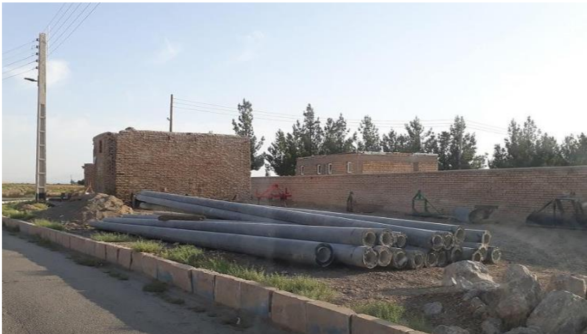
دپوی پایه‌ها به صورت نا ایمن
