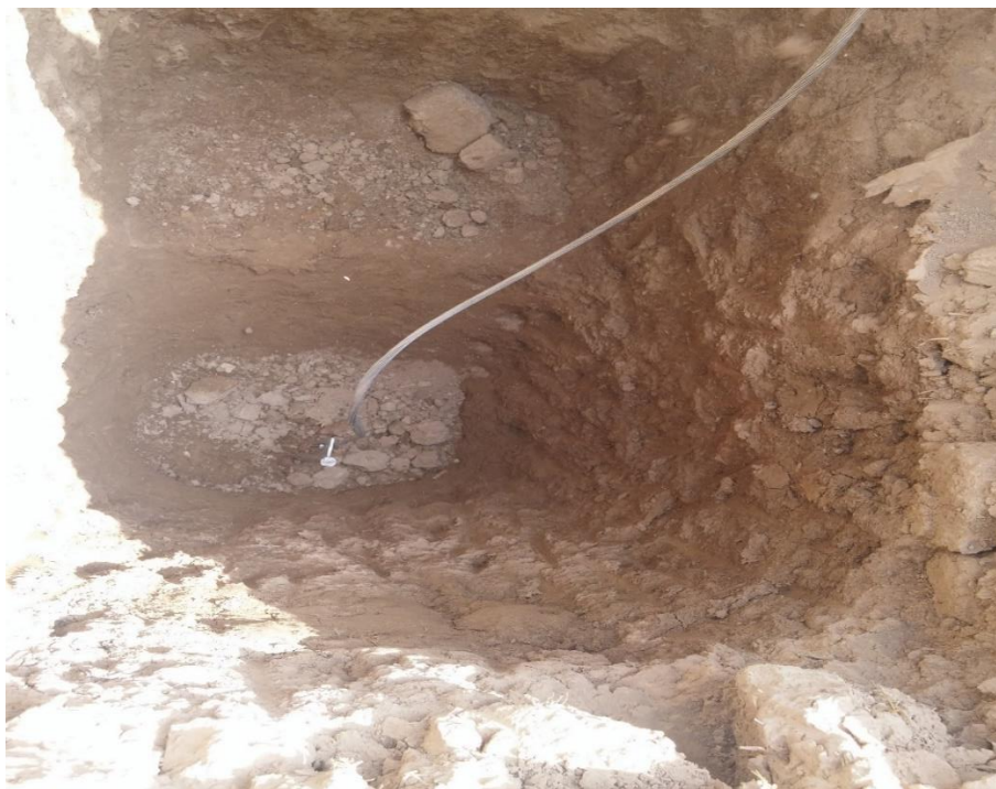
کوبیدن الکتروود میله ای به داخل گود ارت و اتصال هادی به آن
