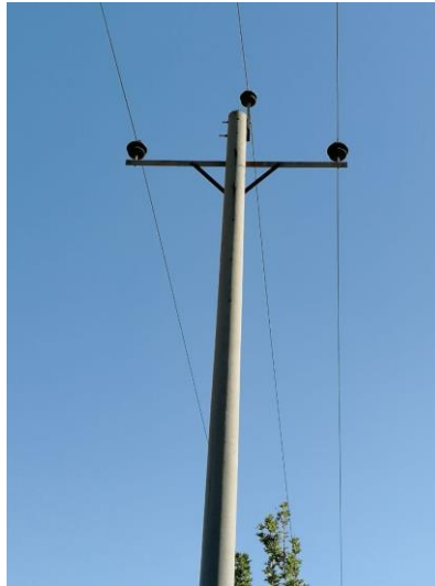
شکل ۱۱۶: آرایش T شکل با کراس آرم بطول ۲۰۰ و باله ۸ سانتیمتر
