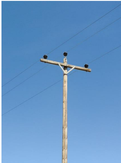
شکل ۱۱۷: TW آرایش T شکل با کراس آرم چوبی (Wood) بطول ۲۴۰ و باله ۱۰ سانتیمتر
