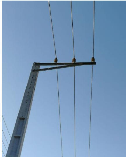
شکل ۱۰۰: آرایش F شکل با کراس آرم بطول ۲۴۰ و باله ۸ سانتیمتر
