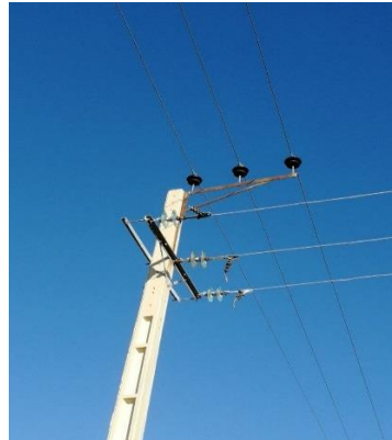
شکل ۱۰۷: آرایش گونیایی Bevel با کراس آرم بطول ۲۰۰ و باله ۷ سانتیمتر جدول ۱۲۷: مشخصات فنی و لیست کالا با آرایش گونیایی و با کراس آرم بطول ۲۰۰ و باله ۷ سانتیمتر
