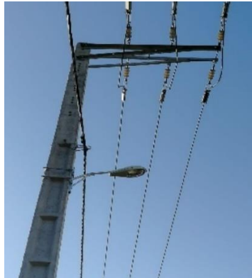
شکل ۱۰۵: آرایش F شکل با کراس آرم بطول ۲۴۰ و باله ۸ سانتیمتر
