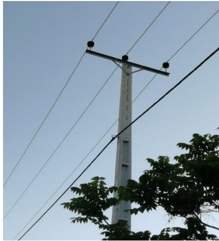
شکل ۹۹: آرایش T شکل با کراس آرم بطول ۲۰۰ و باله ۷ سانتیمتر
