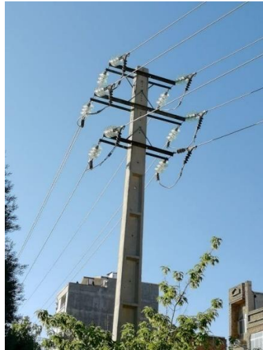
شکل ۱۰۹: آرایش 3T با کراس آرمهایی از بالا به پایین بطولهای ۱۵۰ و ۲۰۰ و ۱۵۰ و باله ۸ سانتیمتر
