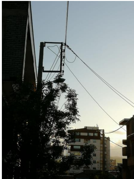
شکل ۱۱۴: آرایش P شکل با ۵ اتریه و کراس آرم به طول ۹۰ و باله ۷ سانتیمتر
