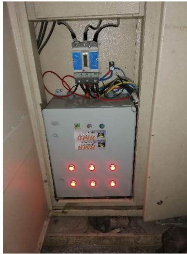
نمونه بانک خازنی نصب شده توسط شرکت بهین مصرف
