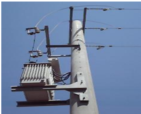
شکل (۷) - تصویر پست هوایی تک پایه بکار رفته در شهرک پرند (تهران)
