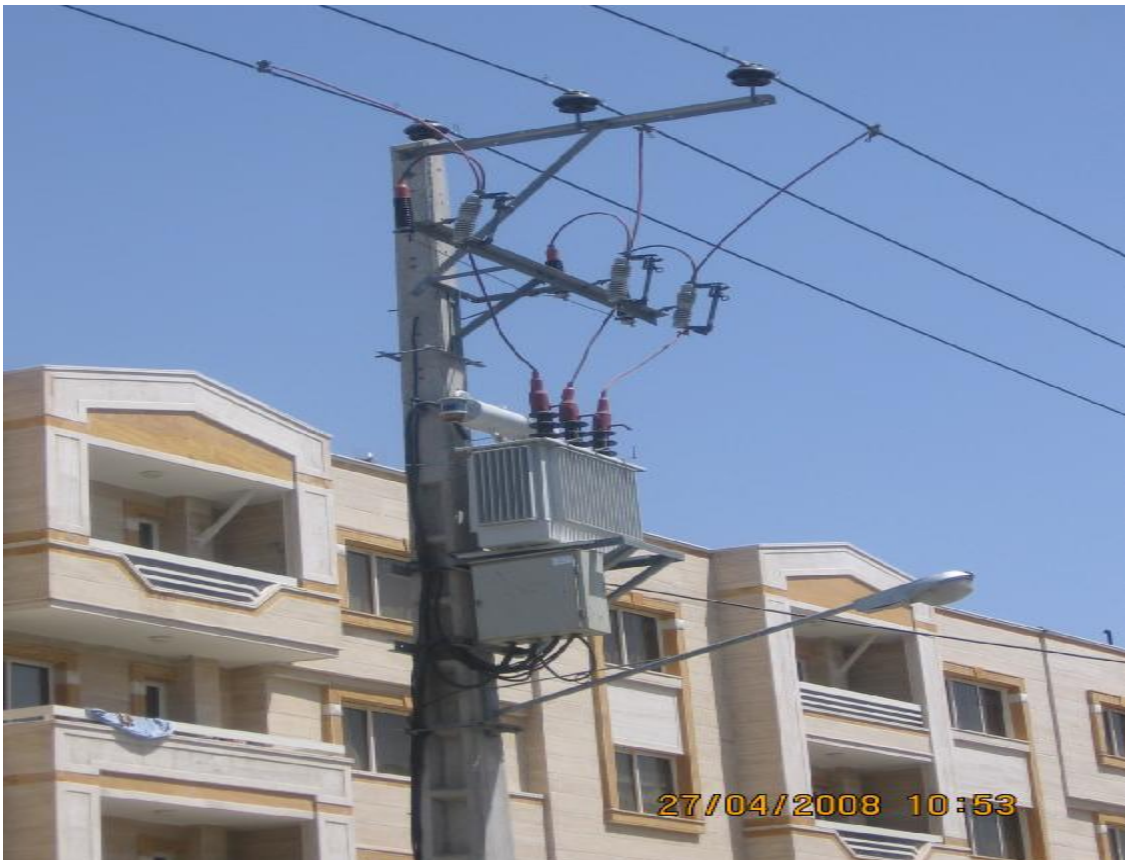
شکل (١٠) - نمونه های اجراء شده نصب پست در شهرستان مشهد
